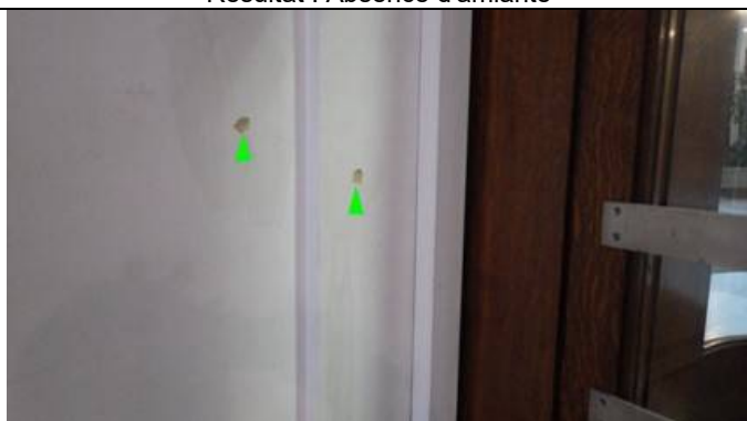
Matériaux : ZPSO-003 et ZPSO-004 Prélèvements P003 et P004 Description : Peinture et enduit plâtreux (sur pierre) Localisation : 82-84, rue des Pyrénées 75020 PARIS Rez de chaussée – Accès Hall d'entrée Mur Gauche et Tableau de porte Gauche Résultat : Absence d'amiante
