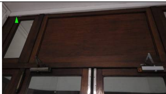
Matériaux : ZPSO-007 – Prélèvement P0017 Description : Peinture et enduit plâtreux sur linteau de porte Localisation : 82-84, rue des Pyrénées 75020 PARIS Rez de chaussée – Accès Hall d'entrée – Linteau de porte Résultat : Absence d'amiante
